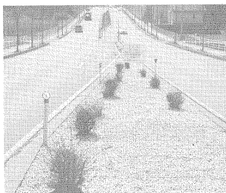
試験施工を行っている佐久市岩村田の国道141号中央分離帯
